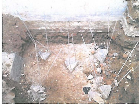
Gambar 3.6. Pemotongan kepala tiang pancang Sumber: dokumen pribadi (2010)
