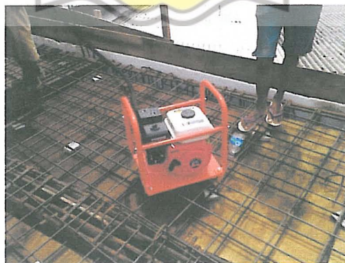
Gambar 3.35. Concrete Vibrator Sumber : Dokumen pribadi (2010)
