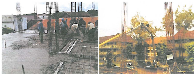
Gambar 3.25. Proses pengecoran plat lantai dan balok
