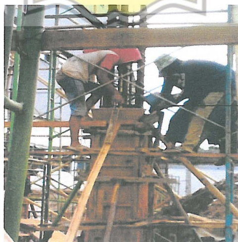
Gambar 3.17. Beton dituang dalam bekisting
