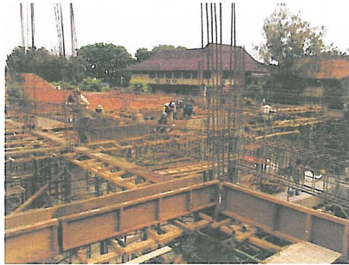
Gambar 3.19. Bekisting balok
