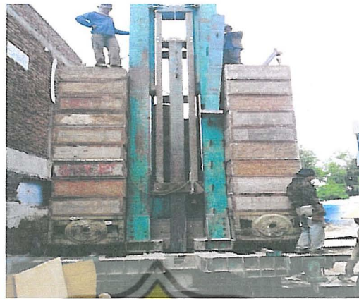
Gambar 3.1. Pekerjaan Pemancangan Sumber: dokumen pribadi (2010)
