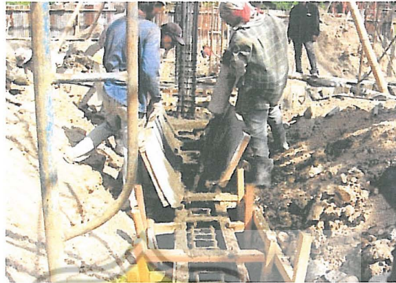
Gambar 3.12. Pengecoran tie beam
