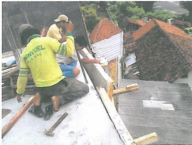
Gambar 3.27 Pelepasan bekisting balok dan plat lantai Sumber : dokumentasi Pribadi (2010)
