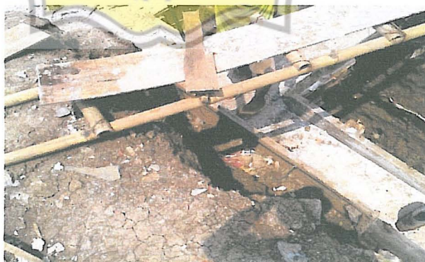
Gambar 3.8. Bekisting pile cap dengan Multiplek Sumber: dokumen pribadi (2010)
