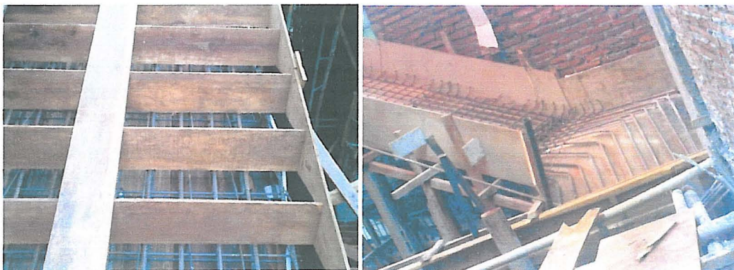
Gambar 3.28. Penulangan tangga
