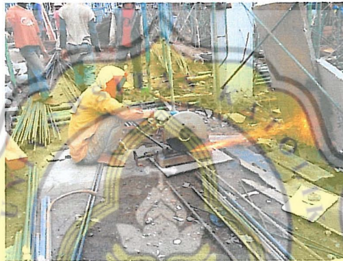
Gambar 3.41 Alat pemotong tulangan dengan listrik
