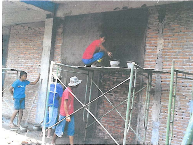
Gambar 3.31. Proses pekerjaan plesteran dinding Sumber : dokumentasi pribadi (2010)
