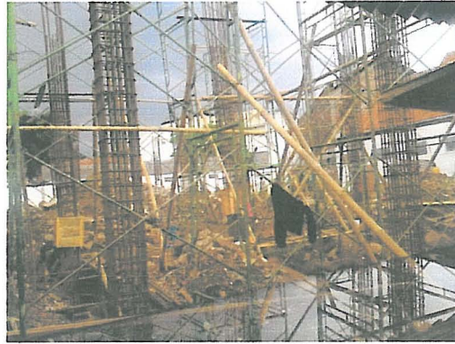
Gambar 3.13. Penulangan kolom
