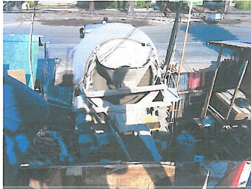
Gambar 3.50. Beton ready mix Sumber : Dokumen pribadi (2010)
