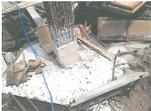
Gambar 3.10. Pengecoran pile cap
