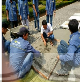
Gambar 4.35. Meratakan Beton Dalam Bekisting
