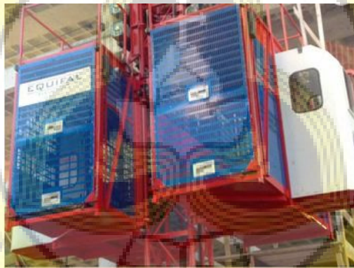
Gambar 5. Hoist untuk distribusi bahan baku
