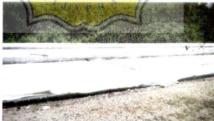
Gambar 3. 17 Pemeliharaan setelah pengecoran lantai kerja (Sumber: dokumentasi pribadi)
