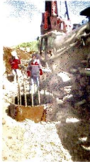
Gambar 3. 9 Pengecoran lubang bor dengan Ready Mix (Sumber: Dokumentasi Pribadi)
