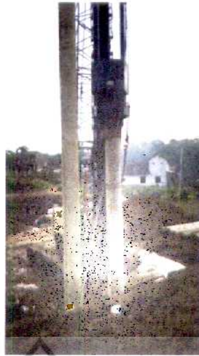
Gambar 3. 33 Alat Diesel Hammer (Sumber: dokumentasi pribadi)
