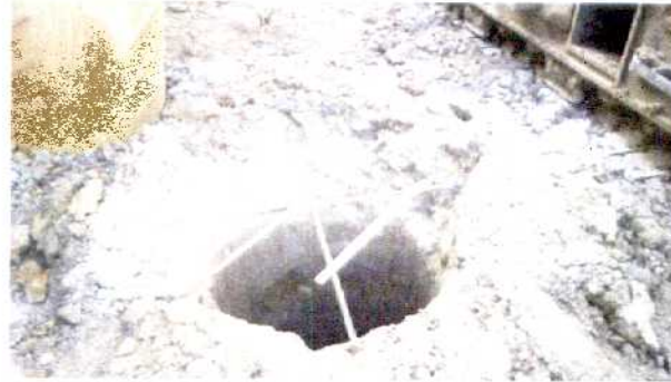
Gambar 3. 5 Lubang hasil pengeboran diameter 100cm (Sumber: dokumentasi pribadi)
