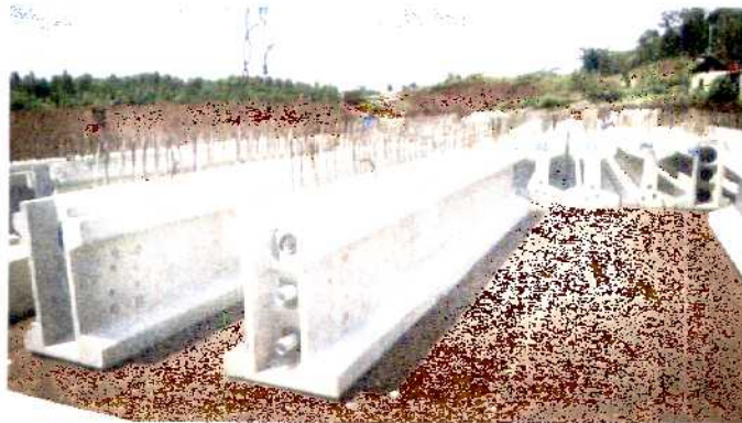
Gambar 3. 38 Balok Girder (Sumber: dokumentasi pribadi)
