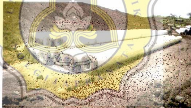
Gambar 3. 37 Spun Pile (Sumber: dokumentasi pribadi)
