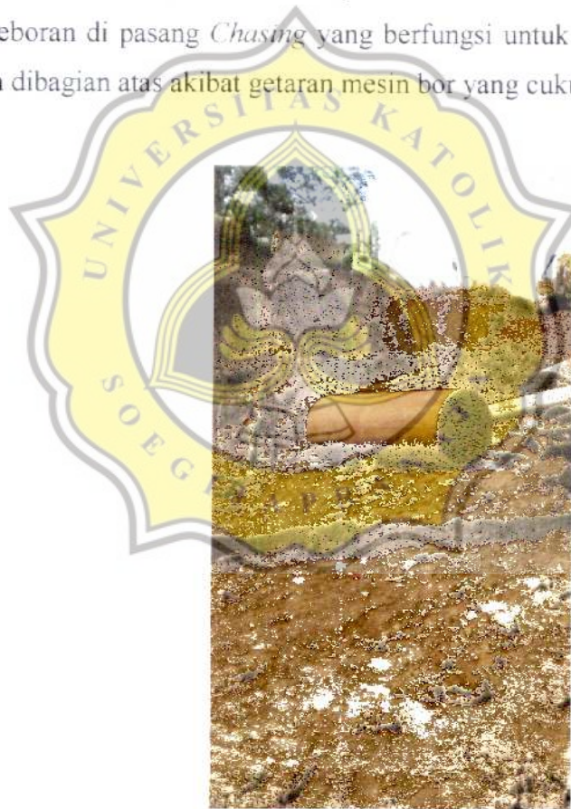
Gambar 3. 6 Chasing untuk menahan runtuhnya tanah akibat getaran mesin bor (Sumber: dokumentasi pribadi)
