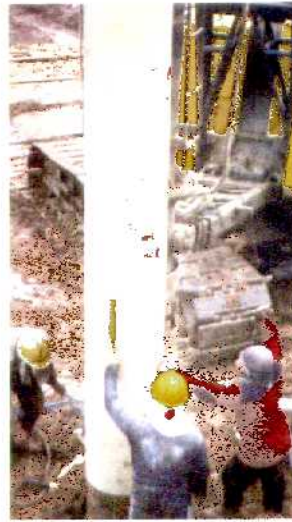
Gambar 3. 12 Pekerja menggunakan alat Waterpass untuk mengetahui tegak lurus tiang Spun Pile
