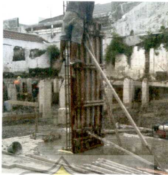
Gambar 5.8: Pemasangan bekisting kolom (sumber: dokumentasi pribadi,2013)
