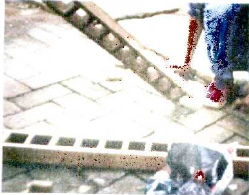
Pembuatan Bekisting Mortar Ukuran
