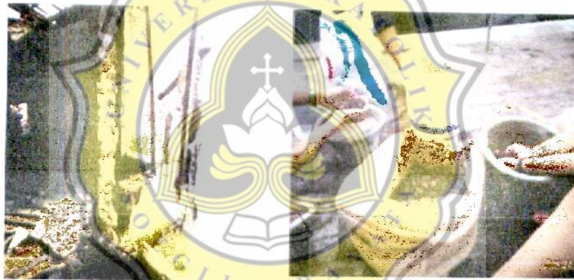
Kolom Setelah dibobok
