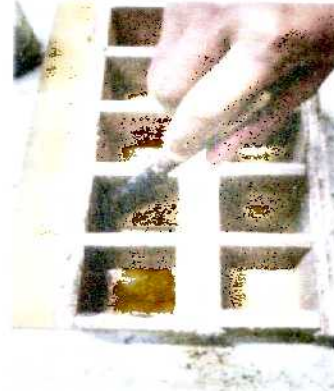
Pengolesan Bekisting dengan
