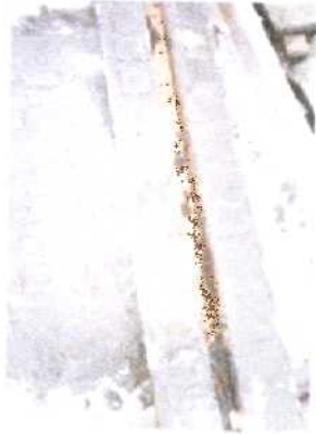
Mortar yang masih basah
