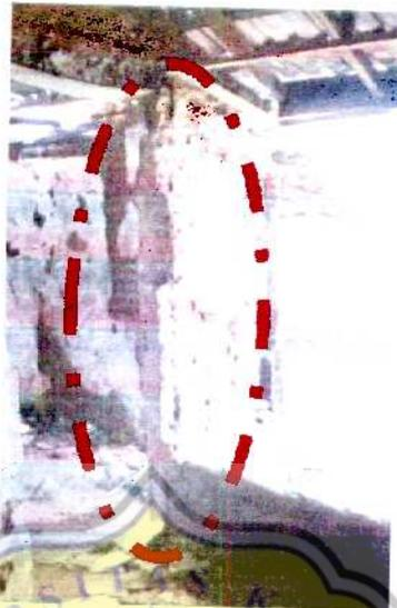
Gambar 1.3 Kolom Beton yang digrouting
