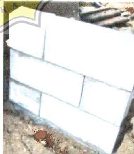
Memasang bata beton
