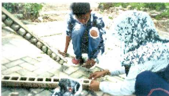
Pembuatan bekisting kubus mortar
