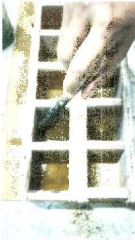
Mengoleskan oli pada bekisting
