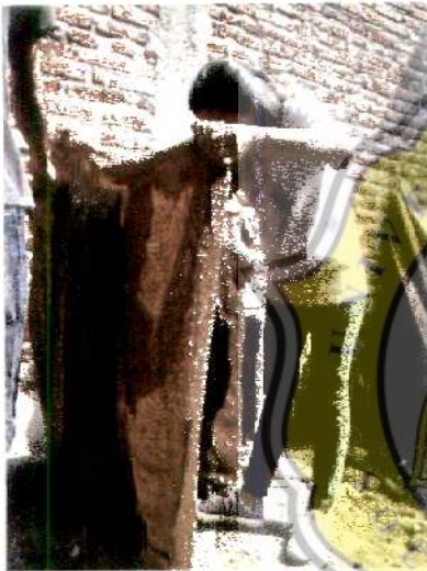
Perawatan Kolom Dengan Diselimuti Karung Goni
