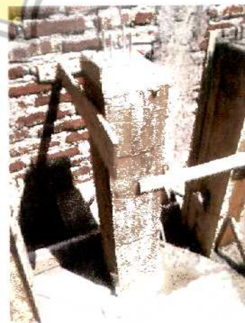
Pembuatan Kolom Di Pucang Gading Selesai Dan Kemudian Ditunggu Sampai Usia Kolom 2 Hari Dan Kemudian Dilakukan Pembongkaran Bekisting
