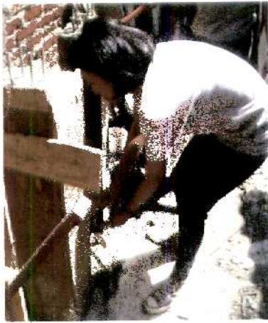
Pembongkaran Bekisting Kolom Di Pucang Gading
