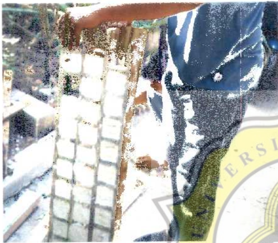
Pelepasan Mortar Dari Bekisting Setelah 2 Hari
