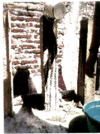
Perawatan Kolom Dengan Air Tawar
