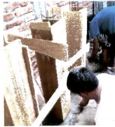
Pemasangan Papan Bekisting Kolom Di Pucang Gading
