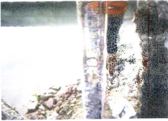
Menyelimuti Kolom yang Akan Diperbaiki dengan Kawat Ayam
