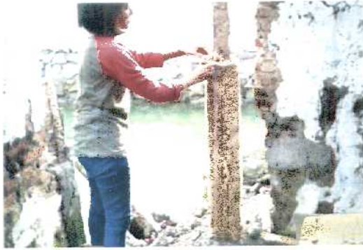
Perawatan Kolom dengan Menggunakan Kain Goni yang Dibasahi dengan Air Rob
