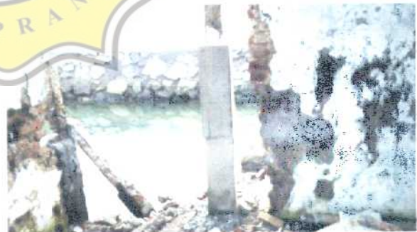
Pembongkaran Bekisting
