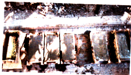
Saat Dituang ke dalam Bekesting/Cetakan Bata Beton Pejal
