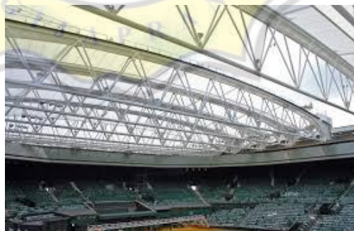
Gambar 3.25 : Atap Space Truss Sumber : Rumahakyat.org
