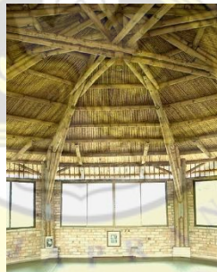
Gambar 3.10 penerapan bambu sepai struktur atap
