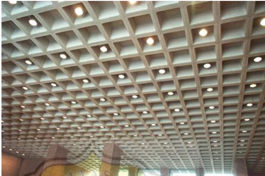
Gambar 3. 21 Konstruksi Lantai Jenis Waffle Slab Sumber: civilengineersforum.com
