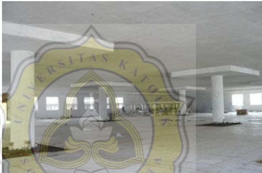
Gambar 3. 20 Konstruksi Lantai Sistem Flat Slab Sumber: civilengineersforum.com
