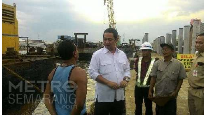
Gambar 88 Walikota Semarang Didepan Pembangunan Proyek
