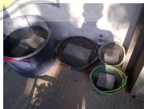
Proses Perawatan atau Curing
