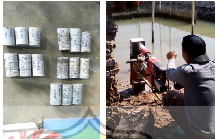
Gambar 4.7 Pengambilan Inti Beton Kolom di Desa Sriwulan, Kecamatan Sayung
