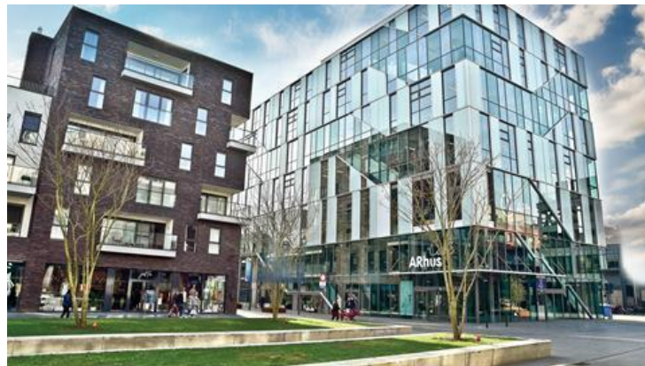
Gambar 2.3. Bangunan Gedung dengan Fasad Curtain Wall Sumber : https://www.propertyweek.com/features , akses 2018
