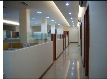
Gambar 3 23 Dinding gypsum Sumber: kiranarayacipta.com
