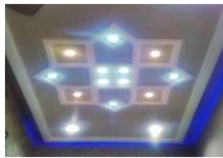
Gambar 4. 30 Plafond GRC Sumber: https://grcbangunpersada.wordpress.com/
