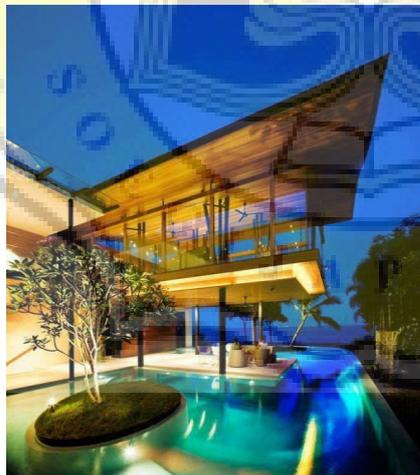
Gambar 5. 1 Penerapan teritisan yang lebar pada fish house
