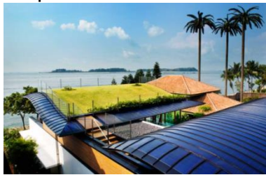
Gambar 5. 4. Penggunaan green roof pada atap
