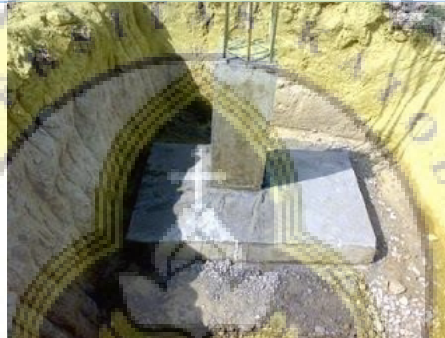
Gambar 58 : Gambar pekerjaan pondasi footplat
