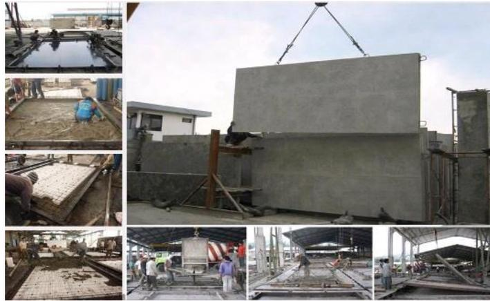
Gambar 3. 19 Konstruksi dinding Beton Precast
