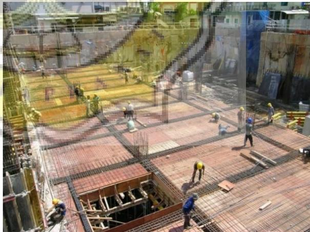
Gambar 3. 15 Struktur Plat Lantai
