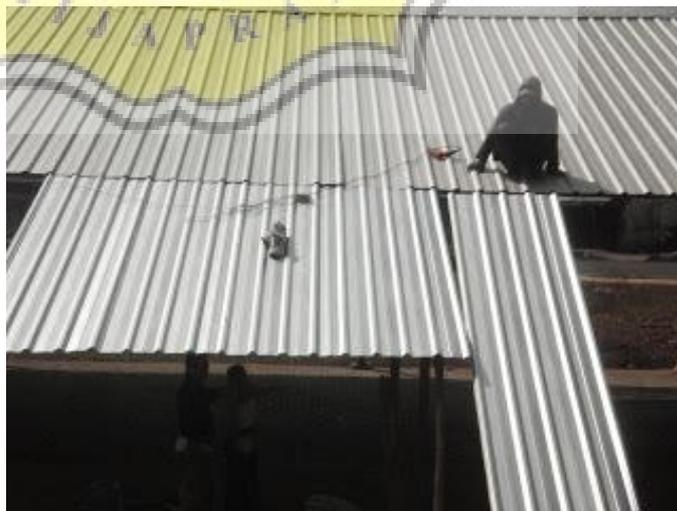
Gambar 3. 20 Pemasangan Penutup Atap Galvalum
