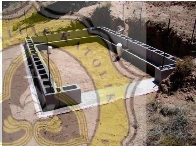
Gambar 3. 18 Konstruksi Dinding Batako
