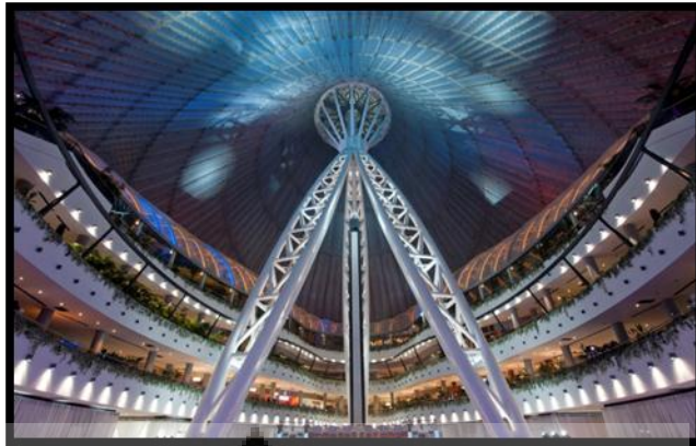
Gambar 141. Tripod Penyangga Bangunan Sumber : www.constructionweekonline.com
