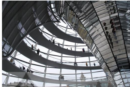
Gambar 114. Interior Reichtag Dome Sumber : www.archdaily.com
