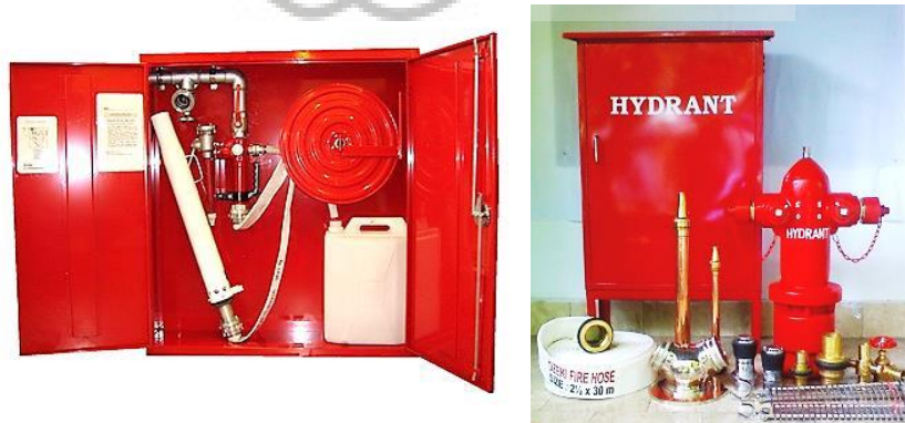
Gambar 4.55 Hydrant box dan Hydrant Pole
