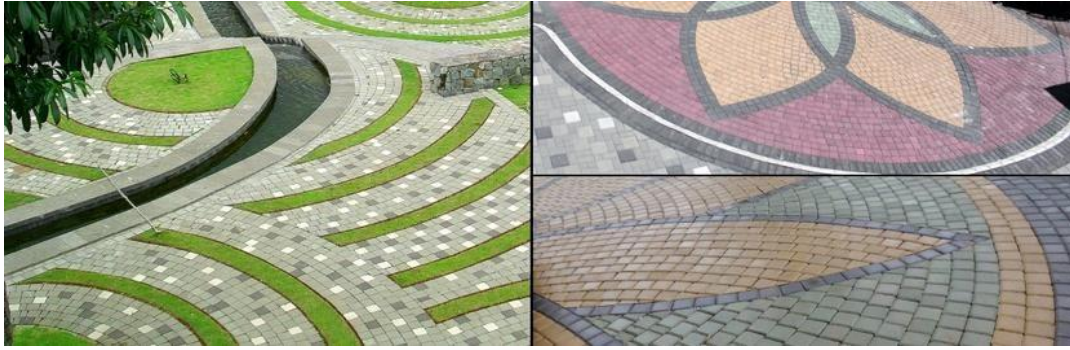
Gambar 5.14 Pedestrian dengan bahan paving block
