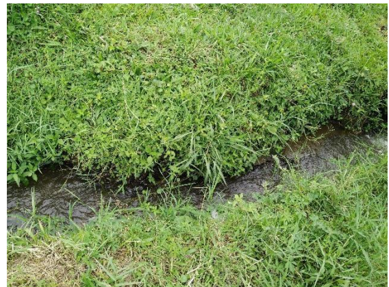
Gambar 3.104 Selokan pada tapak Sumber: Dokumen Pribadi
