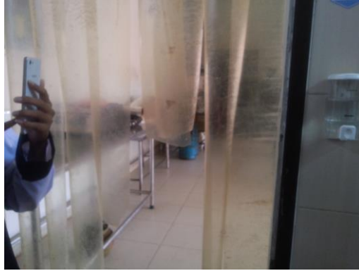
Gambar 10. Kondisi Tirai Pintu
