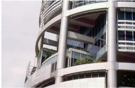
Gambar 5.4 Struktur Menara Mesiniaga Sumber : https://dome.mit.edu diakses 15 September 2016
