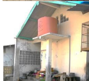
Gambar 6. Jl. Senjoyo V (1). Kondisi jalan yang lebih lebar di salah satu ujungnya, dan terdapat fasilitas MCK umum, serta area jemur pada median jalan. Sumber : Survey peneliti, 2016
