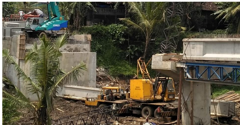
Gambar 3. 26. Perangkaian Segmen Balok Girder sebelah Barat
