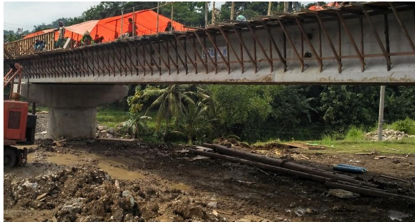
Gambar 3. 30. Rangkaian Balok Girder Bagian Timur
