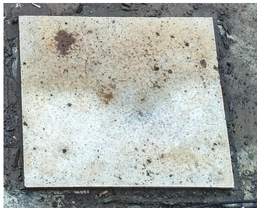
Gambar 3. 9. Peletakkan Bearing Pad
