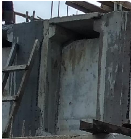
Gambar 3. 21. Ujung Balok Yang Telah Dihaluskan
