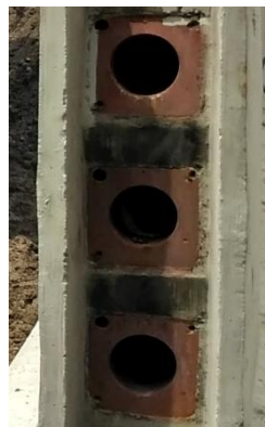
Gambar 3. 12. Duct Pembungkus Kabel Strand
