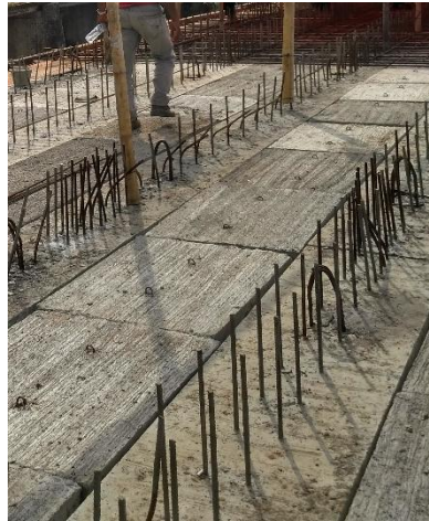
Gambar 3. 39. RC plate yang telah terpasang
