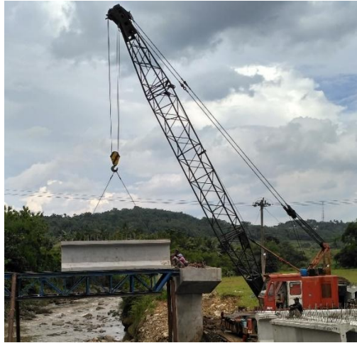
Gambar 3. 11. Peletakkan Balok Girder Keatas Trolley
