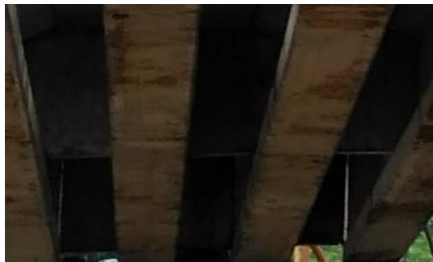
Gambar 3. 36. Balok Diafragma yang Telah Terpasang
