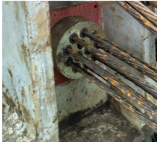
Gambar 3. 16. Pemasangan Wedge Plate Pada Kabel Strand
