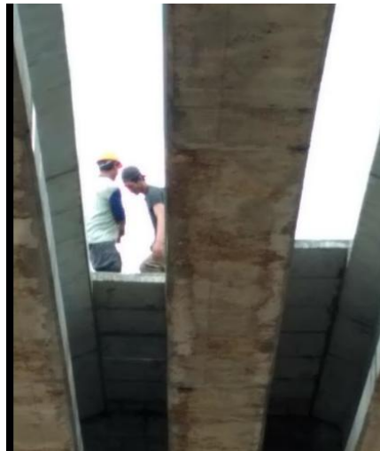
Gambar 3. 38. Proses pemasangan RC plate
