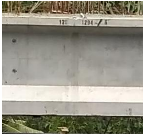
Gambar 3. 19. Hasil Balok Girder Setelah di Stressing
