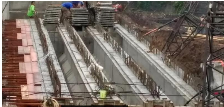
Gambar 3. 35. Proses Pemasangan Balok Diafragma
