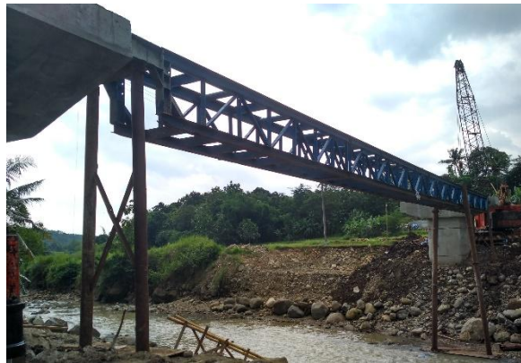
Gambar 3. 7. Perancah di atas Pier Head Timur Dan Pier Head Barat
