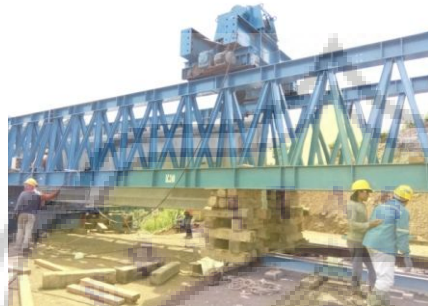
Gambar 3.21 Pengangkatan Girder memakai gantry crane
