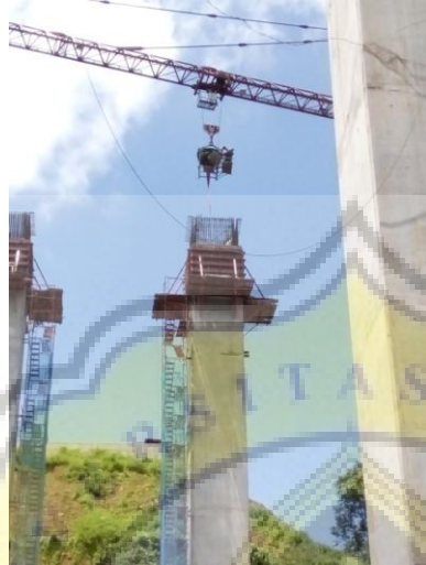
Gambar 3.14 Pengecoran Kolom
