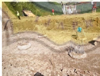
Gambar 3.4 Pembobokan Bor Pile
