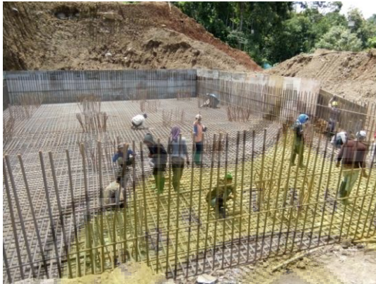
Gambar 3.7 Pemasangan Tulangan Bawah Pile Cap
