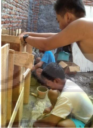
Pemasangan Bekisting Kolom
