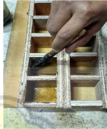
Pengolesan Bekisting dengan Oli
