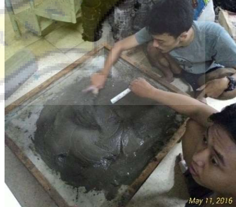
Mortar dimasukan ke Bekisting
