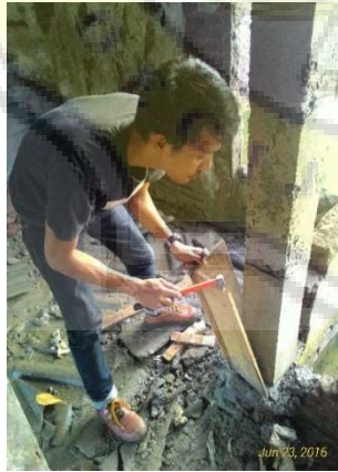
Pembongkaran Bekisting
