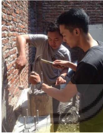
Proses Pembongkaran Bekisting
