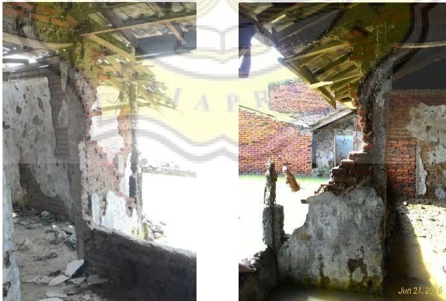
Pemilihan Kolom yang akan digrouting
