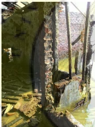
Kolom Setelah dibobok
