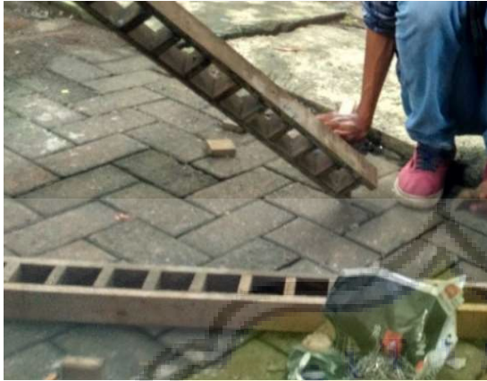
Pembuatan Bekisting Mortar Ukuran 5 x 5 x 5 cm
