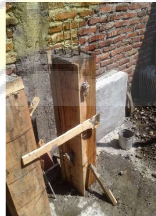
Kolom Beton Kondisi Basah
