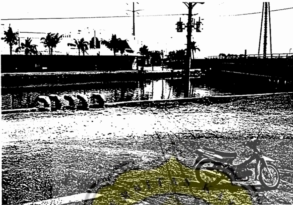
Gambar D. 5 Pipa pembuangan air yang langsung menuju ke Kali Semarang
