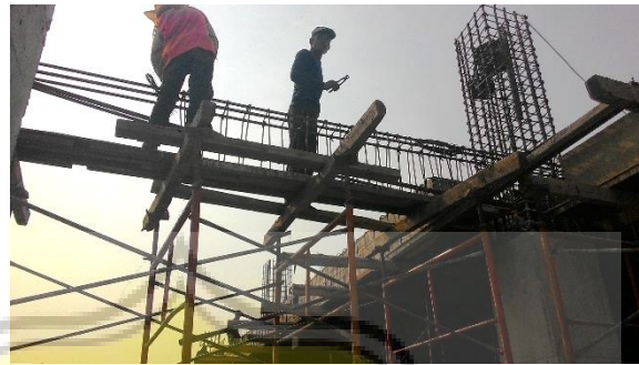
Gambar 3.16 Penulangan Balok
