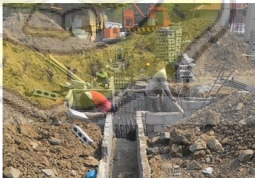
Gambar 3.6 Penulangan Pile Cap
