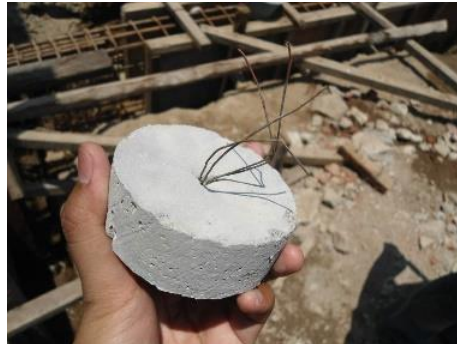
Gambar 3.43 Beton tahu
