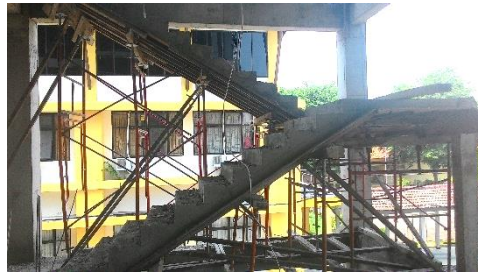
Gambar 3.24 Tangga Yang Baru Di Cor
