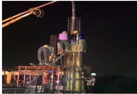
Gambar 3.12 Pengecoran Kolom
