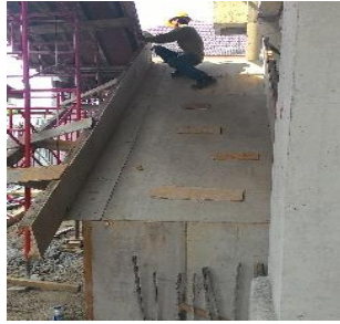
Gambar 3.22 Bekisting Plat Tangga
