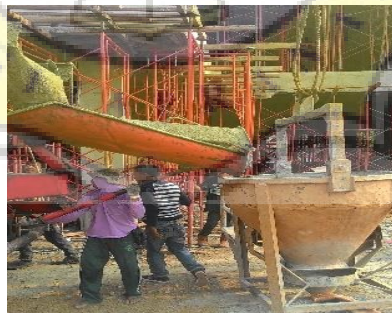
Gambar 3.27 Concrete Bucket Yang Sedang Beroperasi
