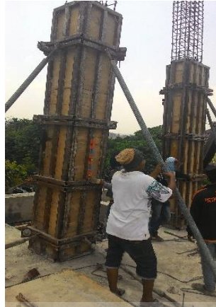
Gambar 3.11 Pemasangan Bekisting Kolom
