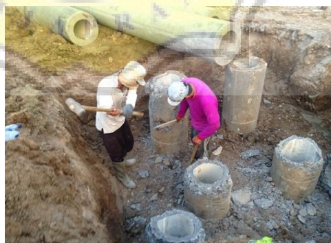
Gambar 3.4 Pemotongan Tiang Menggunakan Palu Godam
