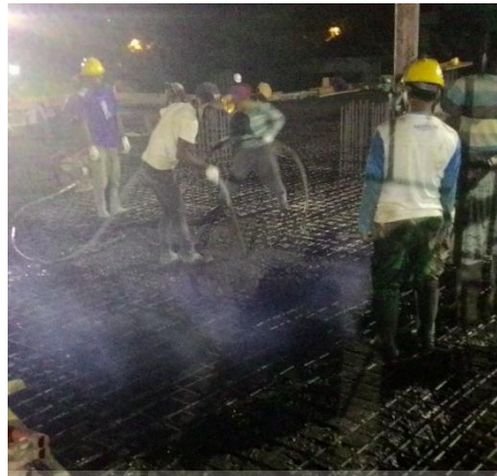
Gambar 3.19 Pengecoran Plat
