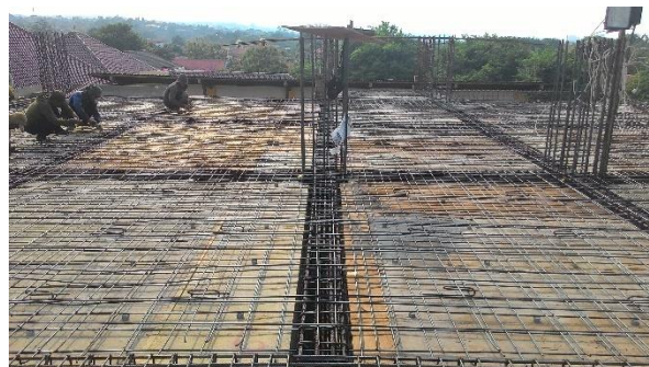
Gambar 3.17 Penulangan Plat Lantai
