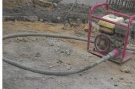
Gambar 3.25 Concrete Vibrator Sumber: Dokumentasi Pribadi, 2015
