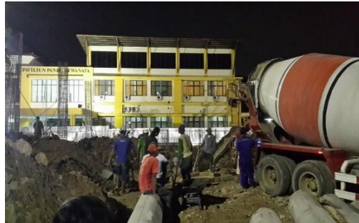
Gambar 3.40 Penuangan Beton ke Bekisting
