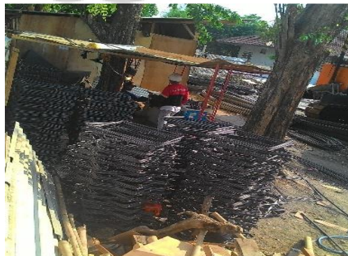
Gambar 3.9 Fabrikasi tulangan sengkang
