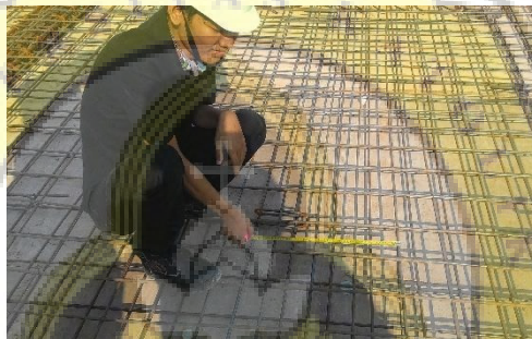
Gambar 3.45 Pengecekan Jarak Besi Cakar Ayam Sumber: Dokumentasi Pribadi, 2015
