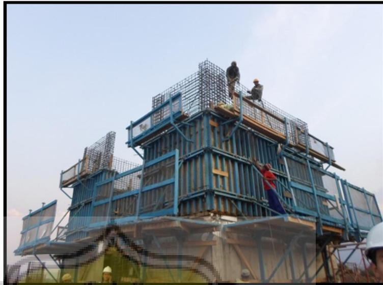
**Gambar 3.15 Pemasangan Bekisting *Shear Wall* dan *Core Wall***
