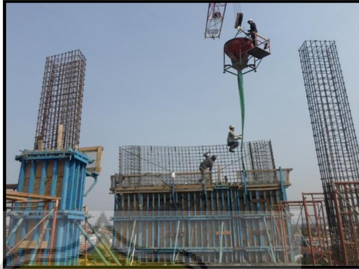
**Gambar 3.16** Pengecoran *Shear Wall* dan *Core Wall*
