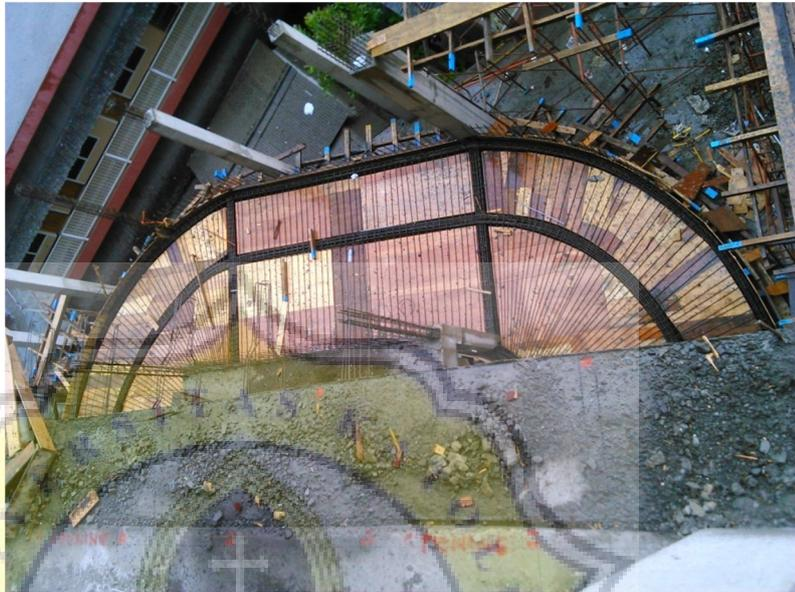
**Gambar 3.17 Pemasangan Bekisting Tangga dan Ram
