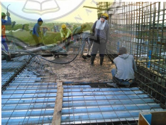
**Gambar 3.13 Pengecoran Balok dan Pelat**
