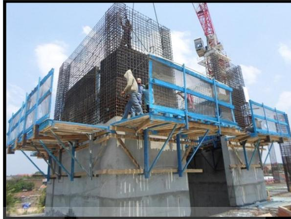
**Gambar 3.14 Pemesian *Shear Wall* dan *Core Wall***
