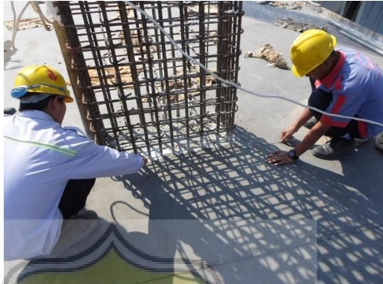
**Gambar 3.7 Pekerjaan Marking Kolom**
