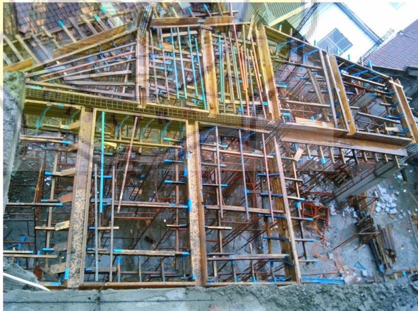
**Gambar 3.11 Bekisting Balok dan Pelat**
