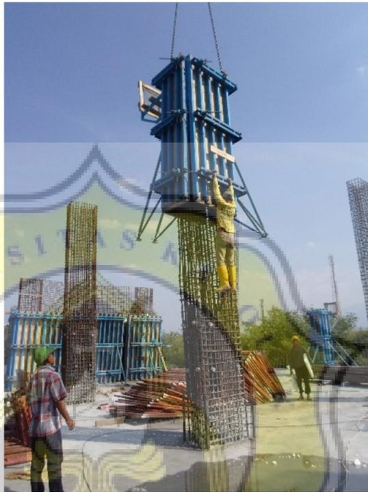
**Gambar 3.9 Pemasangan Bekisting Kolom**
