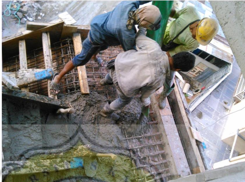
**Gambar 3.19 Pengecoran Tangga dan Ram**
