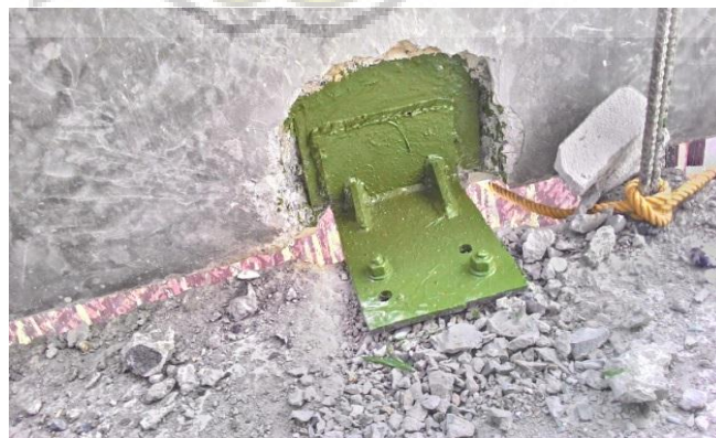
Gambar 3.70 Sambungan antara precast dan plat lantai dengan embeded plate Sumber: Dokumentasi Pribadi, 2015
