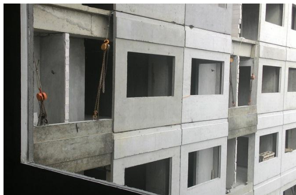
Gambar 3.60 Pemasangan Dinding Precast pada Dinding Gedung bagian luar Sumber: Dokumentasi Pribadi, 2015
