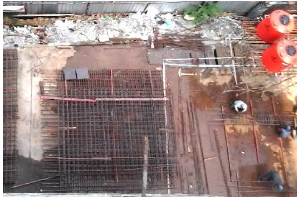
Gambar 3.42 Hasil pembesian shear wall di area fabrikasi besi Sumber: Dokumentasi pribadi, 2015
