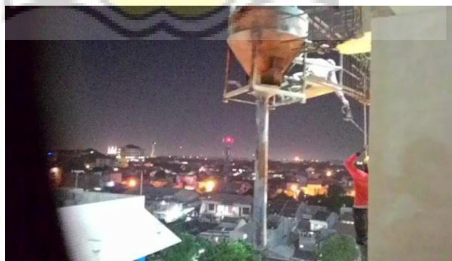
Gambar 3.58 Pengecoran Dinding parapet Sumber: Dokumentasi Pribadi, 2015
