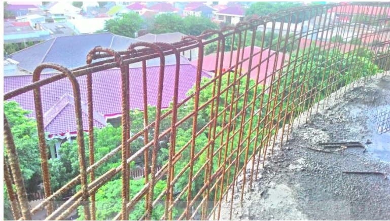
Gambar 3.55 Tulangan dinding parapet Sumber: Dokumentasi Pribadi, 2015
