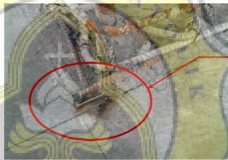
Gambar 3.21 bentuk dari sepatu kolom
