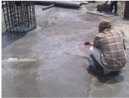
Gambar 3.40 Penyiraman air setelah pengecoran Sumber: Dokumentasi Pribadi, 2015
