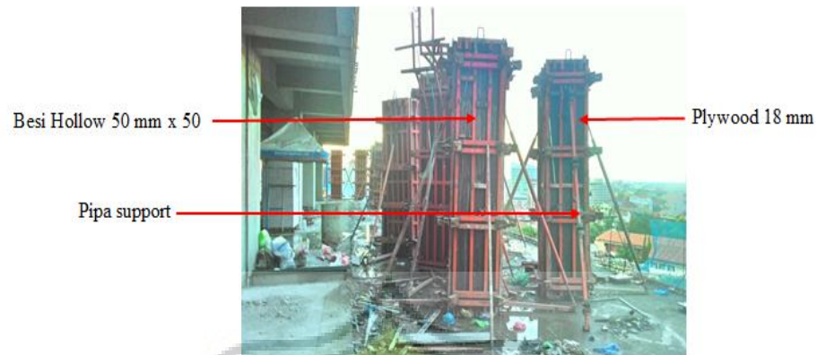
Gambar 3.22 bekisting pada kolom Sumber : Dokumentasi Pribadi, 2015
