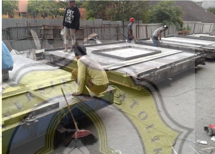
Gambar 3.67 Proses pelepasan bekisting dinding precast Sumber: Dokumentasi Pribadi, 2015
