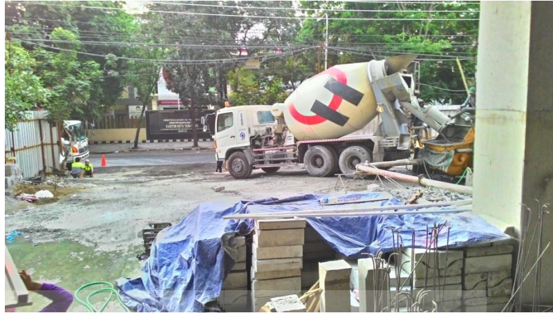
Gambar 3.39 Pengiriman beton dengan Truck Mixer Sumber : Dokumentasi Pribadi, 2015
