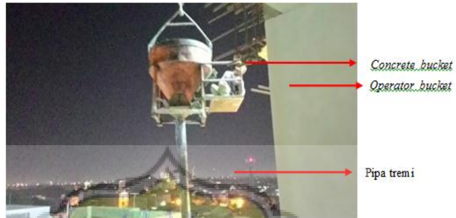
Gambar 3.25 Proses pengecoran pada kolom Sumber : Dokumentasi Pribadi, 2015
