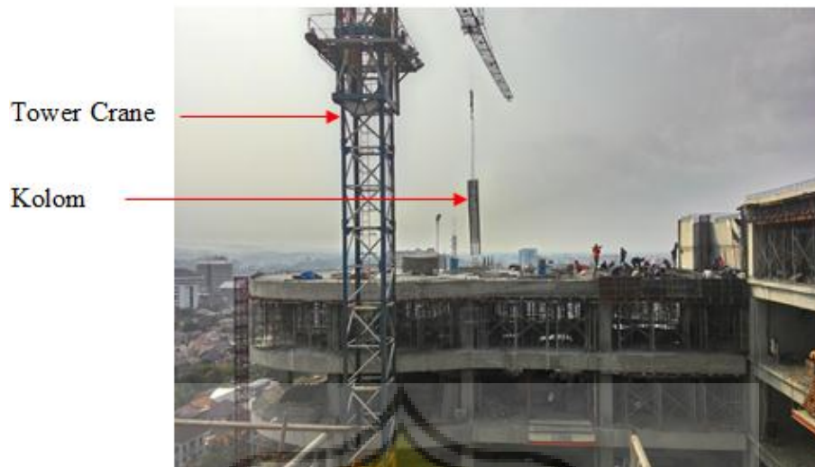
Gambar 3.17 Penyambungan Kolom yang dibantu dengan Tower Crane Sumber: Dokumentasi Pribadi, 2015
