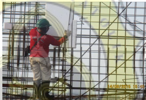
Gambar 3.44 Proses pemasangan block out Sumber: Dokumentasi pribadi, 2015
