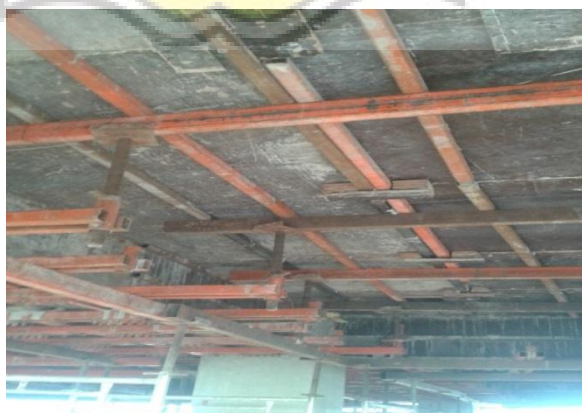
Gambar 3.41 Pelepasan bekisting Sumber: Dokumentasi Pribadi, 2015
