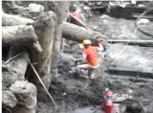
Gambar 3.6 Proses pemotongan kepala tiang pancang Sumber: Dokumentasi Pribadi, 2015
