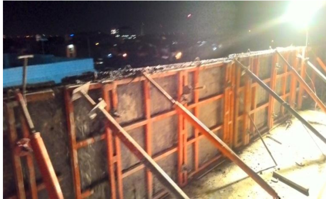
Gambar 3.57 Bekisting parapet Sumber: Dokumentasi Pribadi, 2015
