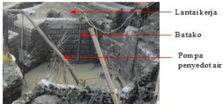
Gambar 3.7 Bekisting pile cap Sumber: Dokumentasi Pribadi, 2015
