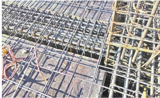
Gambar 3.33 Pemasangan Tulangan Atas dimasukkan ke dalam kolom Sumber : Dokumentasi Pribadi, 2015
