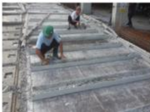
Gambar 3.65 Penyetelan dan pembersihan cetakan Sumber: Dokumentasi Pribadi, 2015
