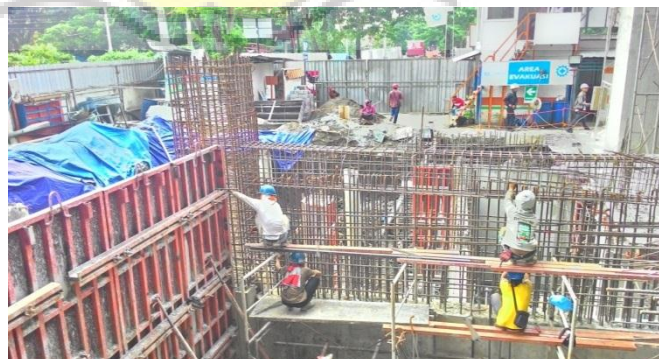
Gambar 3.12 Penulangan retaining wall Sumber: Dokumentasi Pribadi, 2015
