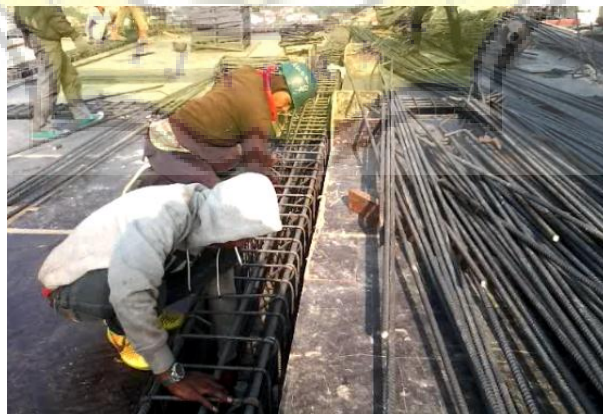
Gambar 3.34 Proses pembesian balok Sumber : Dokumentasi Pribadi, 2015
