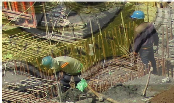
Gambar 3.8 Proses Pembesian pile cap Sumber: Dokumentasi Pribadi, 2015
