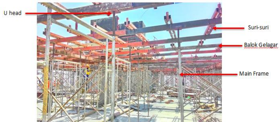
Gambar 3.26 Bagian – bagian Perancah Sumber : Dokumentasi Pribadi, 2015
