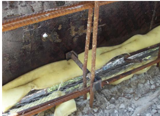
Gambar 3.56 Stop cor bagian bawah tulangan parapet Sumber: Dokumentasi Pribadi, 2015
