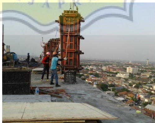
Gambar 3.24 Pemasangan bekisting pada kolom Sumber : Dokumentasi Pribadi, 2015
