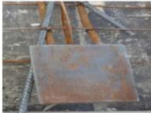
Gambar 3.63 Fabrikasi Plat embedded Sumber: Dokumentasi Pribadi, 2015
