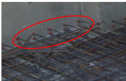
Gambar 3.52 Hasil metode chemset untuk bordes Sumber: Dokumentasi Pribadi, 2015
