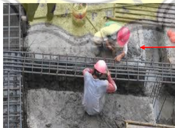
Gambar 3.9 Bekisting tie beam Sumber: Dokumentasi Pribadi, 2015
