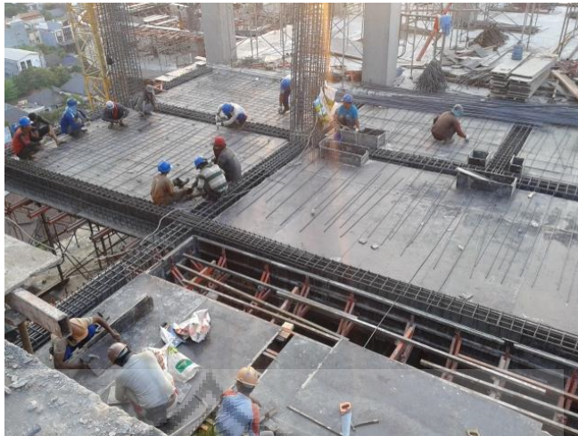
Gambar 3.35 Proses pembesian plat lantai Sumber : Dokumentasi Pribadi, 2015
