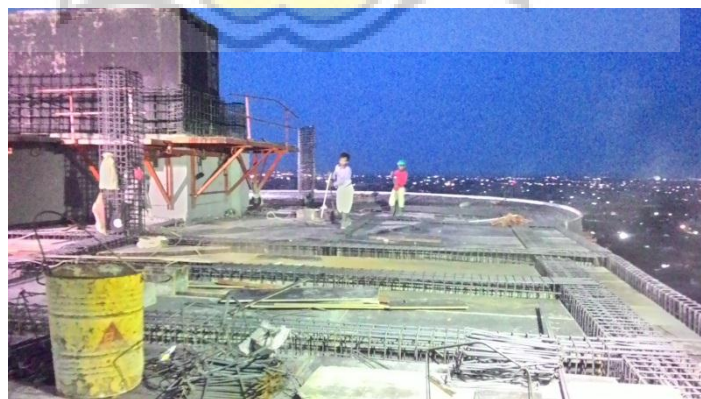
Gambar 3.37 Pembersihan debu dengan Air Compressor Sumber : Dokumentasi Pribadi, 2015
