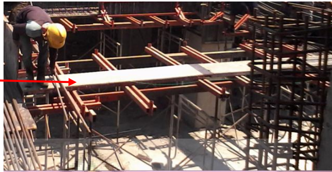
Gambar 3.27 Proses pemasangan Bodeman Sumber : Dokumentasi Pribadi, 2015
