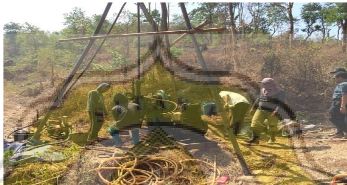
Gambar 3.3 Sondir dan pengeboran tanah
